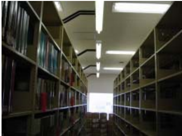
写真 書架に対して直角な照明
